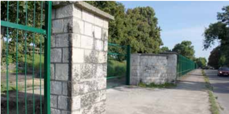
W nowym, kilkusetmetrowym ogrodzeniu wokół stadionu Gwarka, zachowano fragment starego muru.
