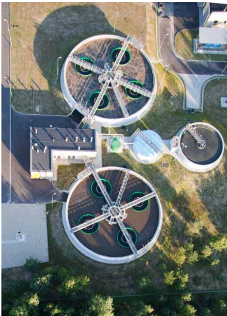
Fot. lotnicza - nowa oczyszczalnia ścieków.
